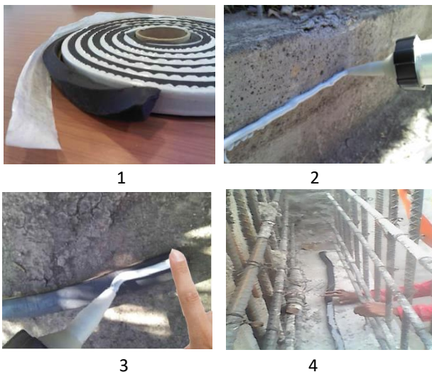
Figura 6 – Cuatro simples pasos en la instalación de Waterstop-RX 101
